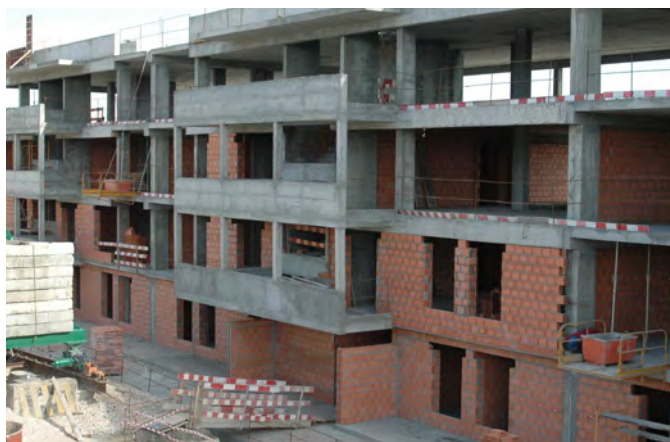
EXECUÇÃO DE ALVENARIA DE TIJOLOS
