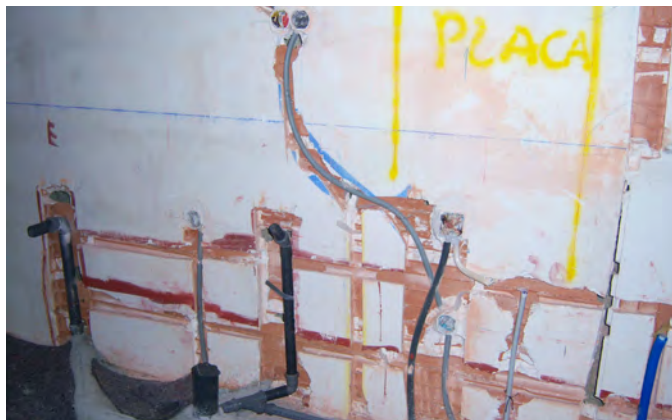
ABERTURA DE ROÇOS NAS PAREDES
