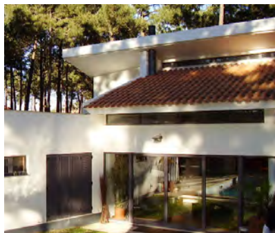
COBERTURA EM TELHADO
