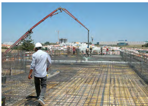
ENCHIMENTO OU BETONAGEM DE UMA LAGE
