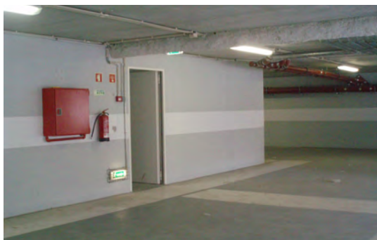
ILUMINAÇÃO DE CAMINHO DE FUGA
