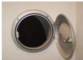
BOCA DE DESPEJO DO LIXO
